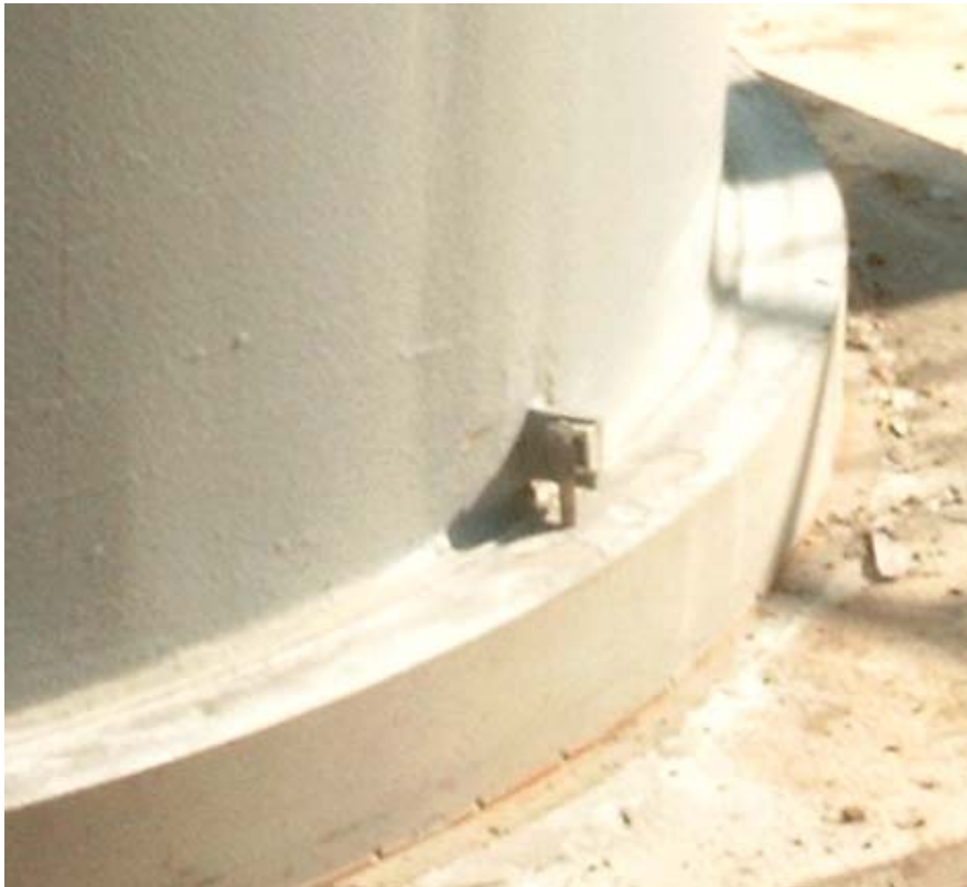
Bild 4 Fertig vergossener Schornsteinfuß mit angeschlossener Erdungsleitung
