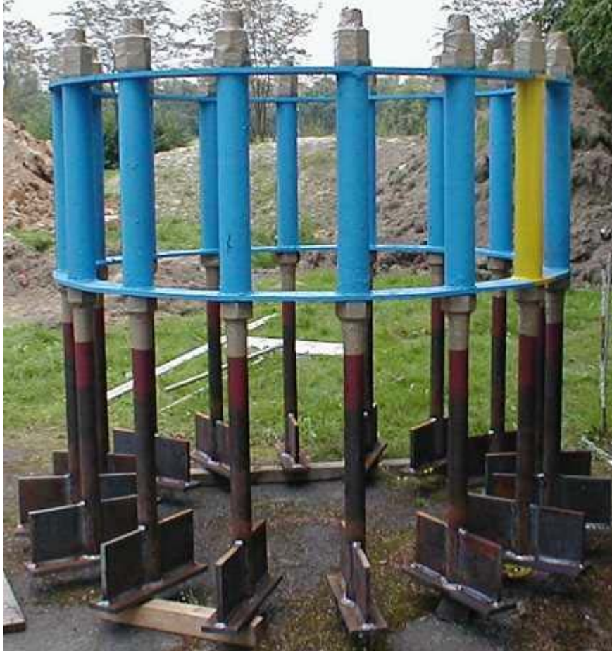
Bild 1 Ankerkorb fertig zusammgebaut, freie Gewindeenden und Muttern abgeklebt
